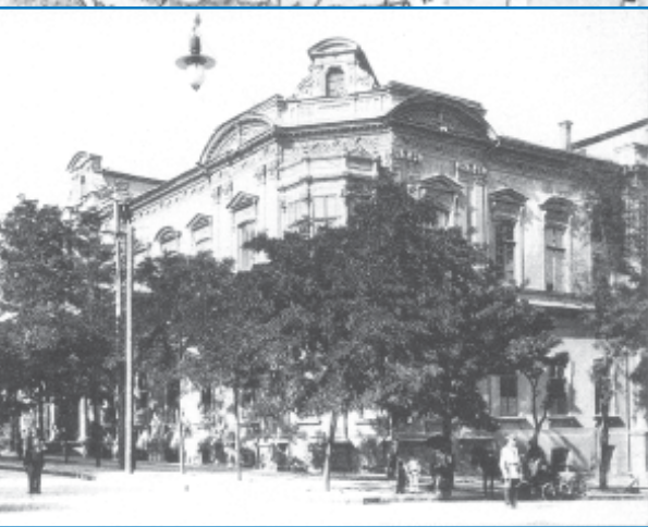
4-я мужская гимназия (Музей западного и восточного искусства) Архитектор Л.Ц. Отон, 1857 г.
