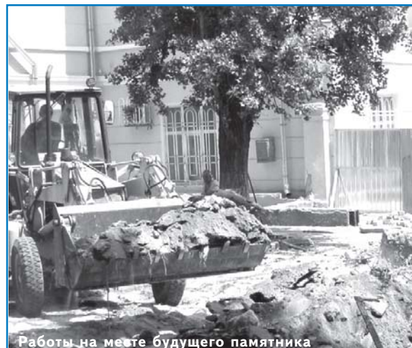
Работы на месте будущего памятника
