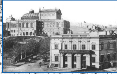
Здание на Думской площади
