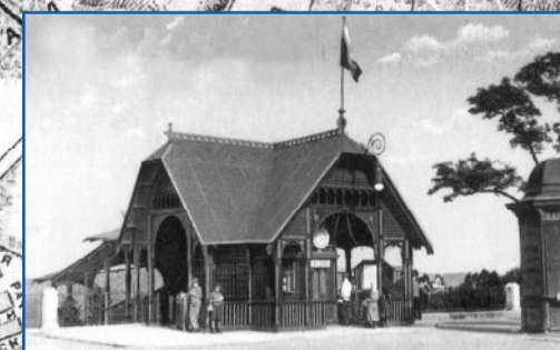
Верхняя станция фуникулера
