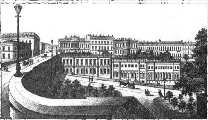
Сабанеев мост. Построен в 1829—31 гг. по проекту арх. Ф.Бюффо в соавторстве с инж. Д.Уптоном. Перестроен арх. Г.Торичелли и инж. А.Казариновым в 1834—36 гг.
