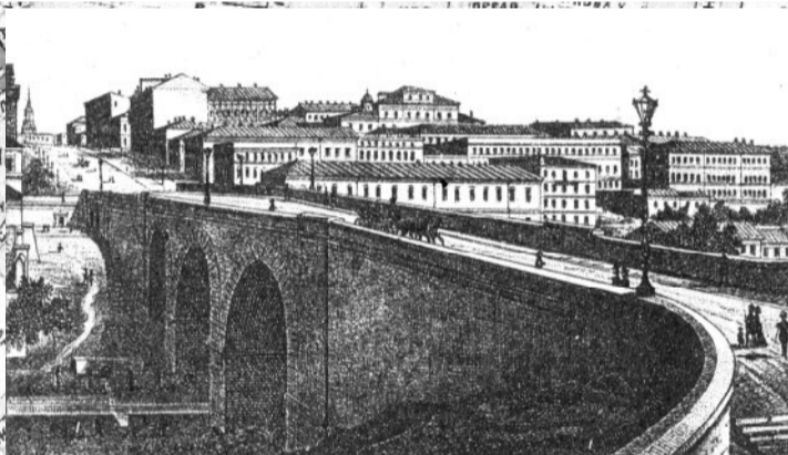
Строгановский мост. Построен в 1863 году по проекту арх. Ф.В. Гонсировского. Назван в честь Новороссийского генерал-губернатора графа А.Г. Строганова. Реконструирован в конце XX ст., внешний вид не восстановлен.
