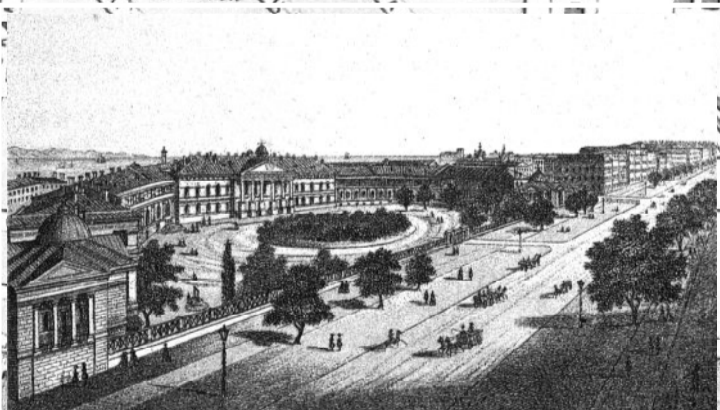
Городская больница, ныне – городская клиническая инфекционная больница, ул. Пастера, 7. Построена при герцоге де Ришелье в 1808 г. по проекту арх. Тома де Томона, Джованни Фраполли.
