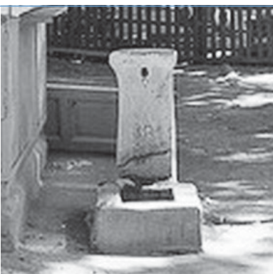
Дворовая водопроводная колонка
